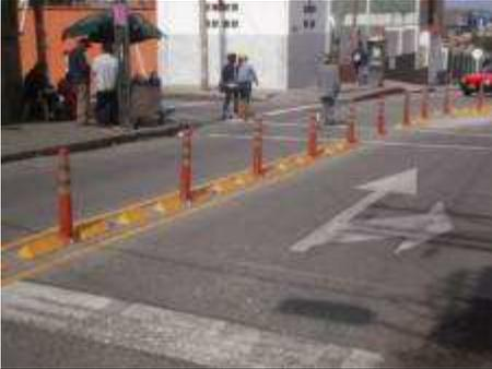
**Foto 1.** Acceso Oriental en la Diagonal 13 sur con Carrera 3G Este, demarcación flechas direccionales y canalización de flujo vehicular con pintura, hitos y tachones. Pintura de larga duración, plástico en frío en elementos de m<sup>2</sup>, que presenta desgaste por las condiciones del pavimento rígido. Implementado en octubre de 2.012.
