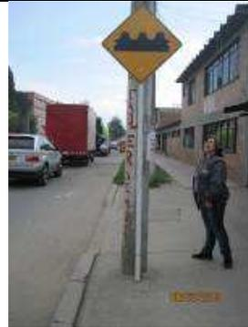
**Foto 4.** Corredor Avenida Versailles carrera 116 entre calle 22I y calle 22 J, instalación de reductores de velocidad portátiles y señales verticales informativas SP-24 superficie rizada, implementación emergencia. Dispositivos en buen estado, implementados en octubre de 2.012
