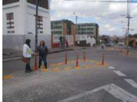
**Foto 2.** Detalle marcas viales de ceda el paso e isleta canalizadora conformada con hitos y tachones en el acceso Oriental de la Diagonal 13 sur con Carrera 3G Este. Pintura de larga duración, plástico en frío, con desgaste por las condiciones del pavimento rígido. Implementación: octubre de 2.012.
