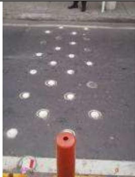
**Foto 7.** Detalle de banda reductora de velocidad con estoperoles implementada sobre la Calle 48 sur, se ausencia de algunos estoperoles por el paso del flujo vehicular, las restantes bandas con estoperol presentan buen estado. Implementado en junio de 2012.
