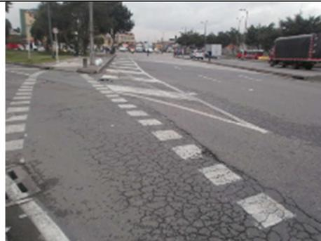
**Foto 6.** Corredor Avenida Ciudad de Cali, pictogramas para señalización corredor cicloruta, pintura acrílica de corta duración por estado de pavimento implementada en el mes de Octubre de 2.012 identificador MV\_AV\_CALI\_941\_090
