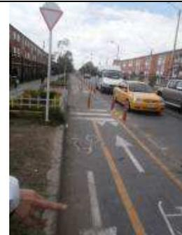
**Foto 10.** Segregación de carriles exclusivos para bicicletas – Bicicarriles – en la Carrera 88 C, incluye marcas viales de ciclorruta y separación del flujo mixto con demarcación lineal, tachas, tachones e hitos. Pintura de baja duración, acrílica. Implementado en octubre de 2012.
