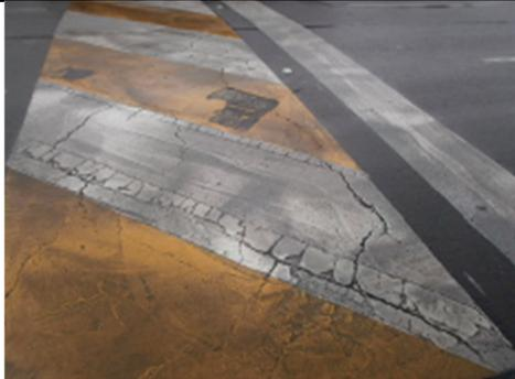
**Foto 3.** Corredor Avenida José Celestino Mutis, Resalto virtual en pintura Plástico en Frío, identificador EX\_01\_295\_1236\_11 Pintura de larga duración pintura desgastada, asfalto en malas condiciones implementada el 16 de julio de 2.012.
