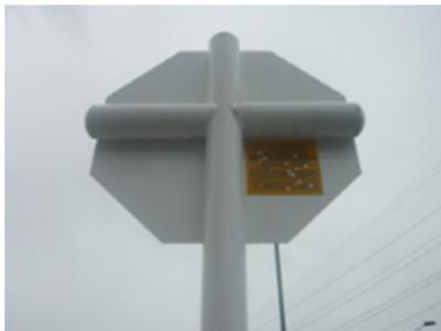
**Foto 9.** Sticker con información básica implementada en cada señal vertical, contiene el número del contrato, la fecha de implementación, localidad y el identificador con el que reposa en la base de datos de la Entidad.
