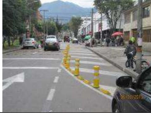
**Foto 8.** Calle 53 B entre avenida NQS y carrera 24, Líneas de carril, líneas de borde, líneas logarítmicas, achurados, flechas, senderos peatonales, hitos, resaltes portátiles y tachones. Pintura Acrílica, ID EX\_13\_220\_1789\_10\_V3, señalización implementada en buen estado fecha de instalación noviembre de 2012.
