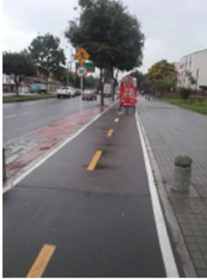
**Foto 1.** Corredor Vial Avenida José Celestino Mutis Con Carrera 75, demarcación de línea borde y eje para la ciclorruta, identificador EX\_01\_295\_1236\_11 Pintura de larga duración Plástico en frío en buen estado implementada el 16 de julio de 2.012.
