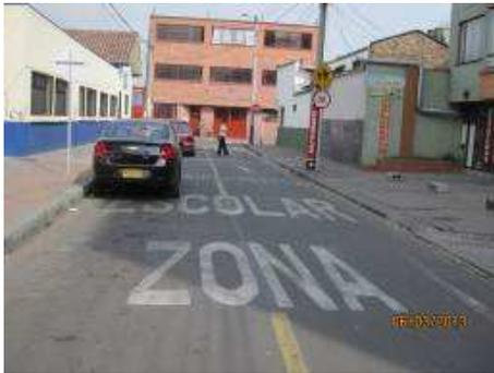
**Foto 3.** Calle 16J entre carrera 99 y carrera 100, estoperoles, pictogramas de zona escolar y línea central, pintura acrílica, identificador EX\_01\_295\_1236\_11. Pintura de larga duración en buen estado implementada el 16 de julio de 2.012.
