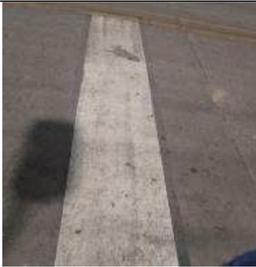
**Foto 3.** Detalle de una franja del dispositivo reductor de velocidad logarítmico, ubicado en la Diagonal 13 sur, que presenta desgaste por las condiciones del pavimento rígido. Implementada en octubre de 2012
