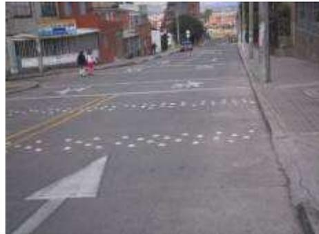
**Foto 4.** Diagonal 13 sur entre Carrera 3G Este y Carrera 3D Este, donde se implementó desarrollo de zona escolar para los sentidos de operación de la vía (conformado por bandas sonorizadoras en estoperol, pictograma de zona escolar, senderos peatonales y resalto virtual). Pintura de larga duración, plástico en frío en m<sup>2</sup>, y base solvente, en ml, en buenas condiciones. Implementado en octubre/12.
