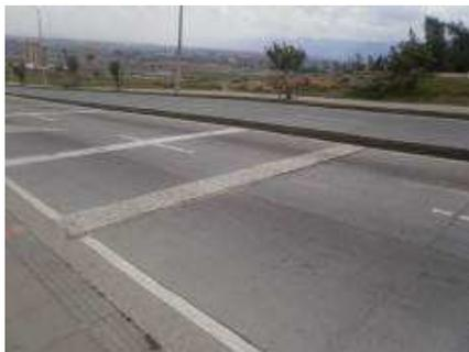
**Foto 9.** Banda reductora de velocidad en agregado implementada sobre la Avenida Gaitán Cortes (Tv. 60), la cual presenta buenas condiciones. Implementada en agosto de 2012.
