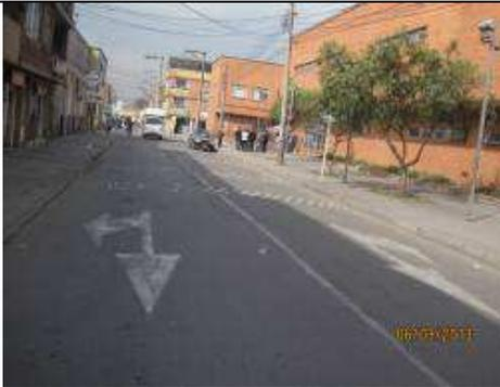
**Foto 1.** Carrera 99 entre calle 16J y calle 16I, demarcación de línea eje estoperoles y flechas, identificador ZE\_09\_364\_989\_09. Pintura acrílica y dispositivos con desgaste implementados el 08 de junio de 2.012.
