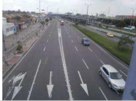
**Foto 6.** Corredor Avenida Américas – calzada Sur mixta, vista al occidente demarcación de carriles, flechas direccionales, línea de borde, tachas, achurados, entre otros elementos. Pintura de larga duración en buen estado, implementado entre septiembre y octubre de 2012.
