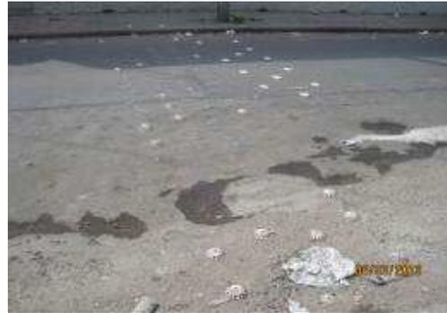
**Foto 2.** Carrera 98 entre calle 17 A y calle 18, estoperoles, identificador ZE\_09\_410\_947\_10\_V1. Dispositivos con desgaste implementados el febrero de 2.012.
