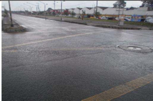
**Foto 5.** Corredor Avenida José Celestino Mutis con Transversal 93, línea antibloqueo, identificador EX\_01\_295\_1236\_11 Pintura de larga duración en regular estado por mal estado del pavimento, implementada el 16 de julio de 2012
