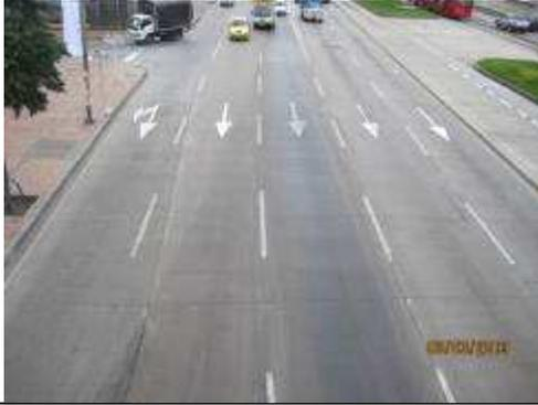
**Foto 7.** Corredor Avenida Carrera 30 entre calle 10 y calle 92, Líneas de carril, líneas de borde, achurados, flechas, senderos peatonales, pintura bicomponente (larga duración) ID SH\_SV\_IDU\_105\_2003, señalización en buen estado, señalización implementada en septiembre de 2012.
